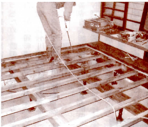
志納所床下のシロアリ防除工事
