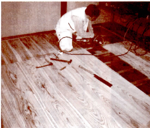
床板を張り直して修復工事も完成
