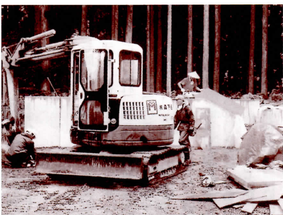
雨降りや日照りの中での移設工事
