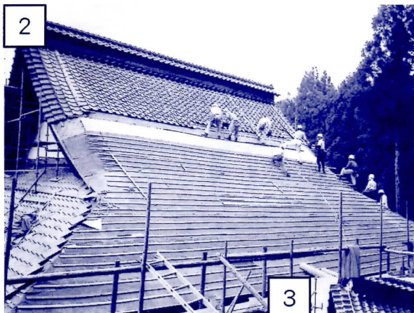
古い瓦を除いたあとに木材等で補修していきます
